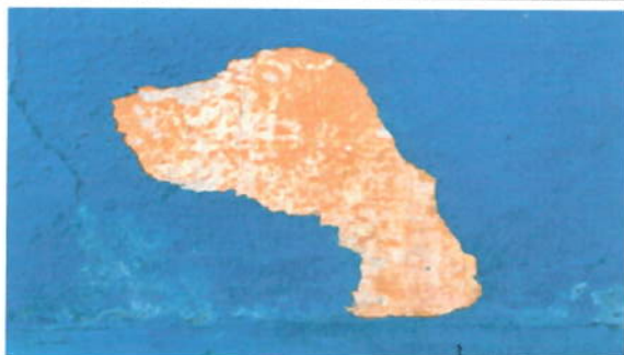
Foto 3: PINTURA EN MUROS EXTERIORES
